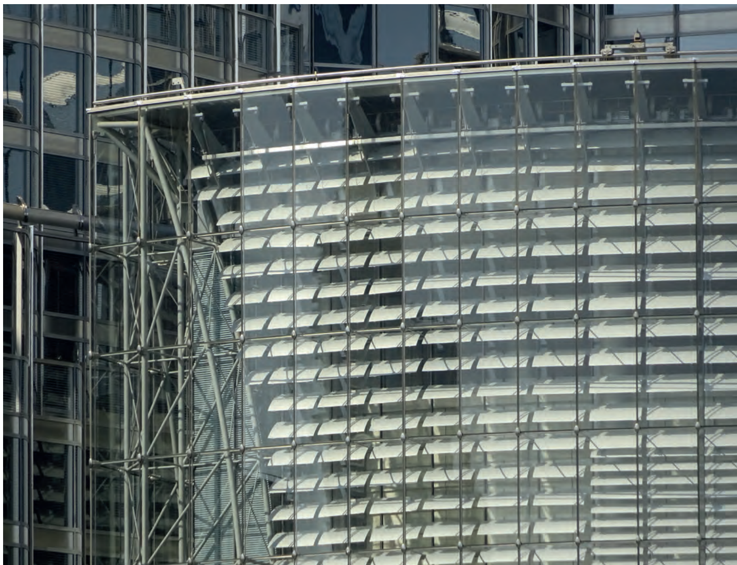
3 – Frangisole orientabili in facciata da doppia pelle al Burj Khalifa, Dubai.
