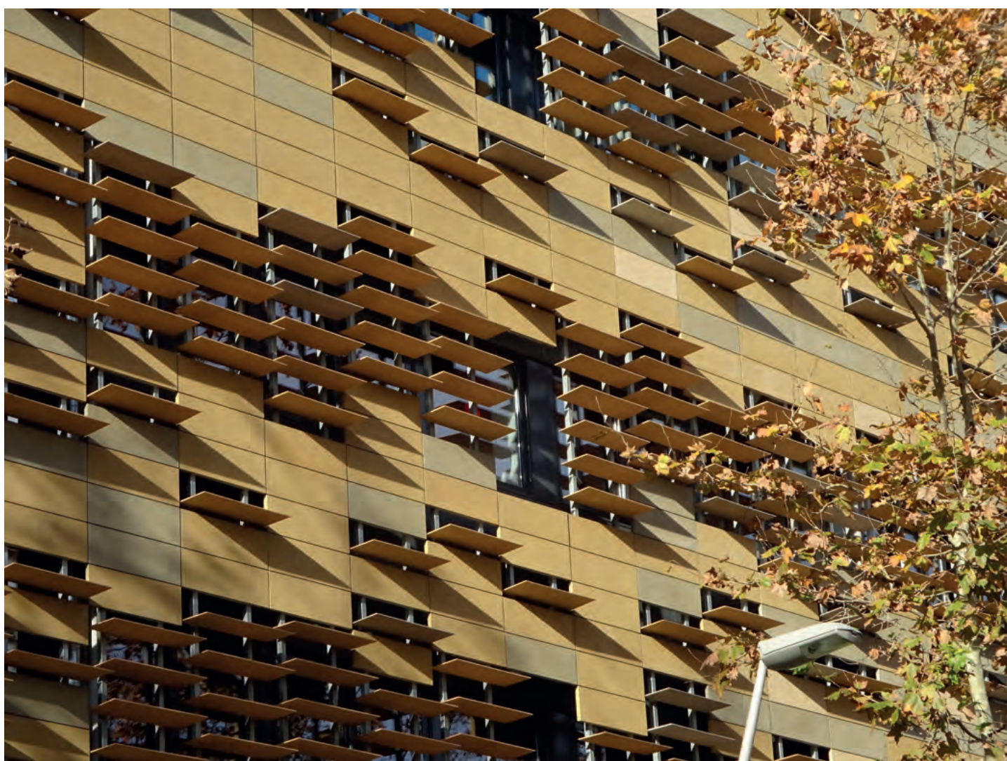
6 – Schermature in materiale composito in un recente edificio in Plaça de Montserrat Casals a Barcellona.
