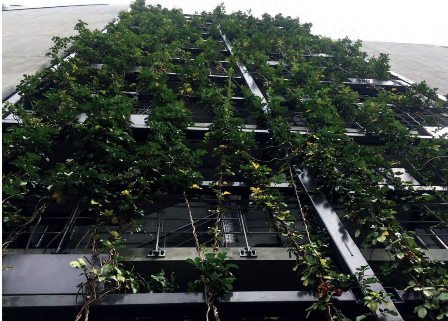
8 – Schermature vegetali sulla facciata del Fonterra Co-operative Group Building, Auckland, Nuova Zelanda.
