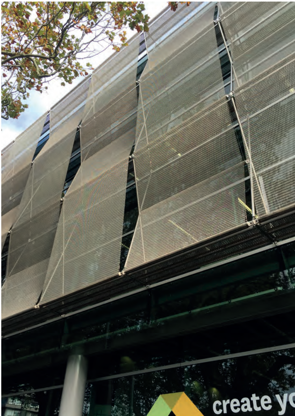
7 – Tessuto metallico sulla facciata principale del Kate Edger Information Commons, Auckland, Nuova Zelanda.
