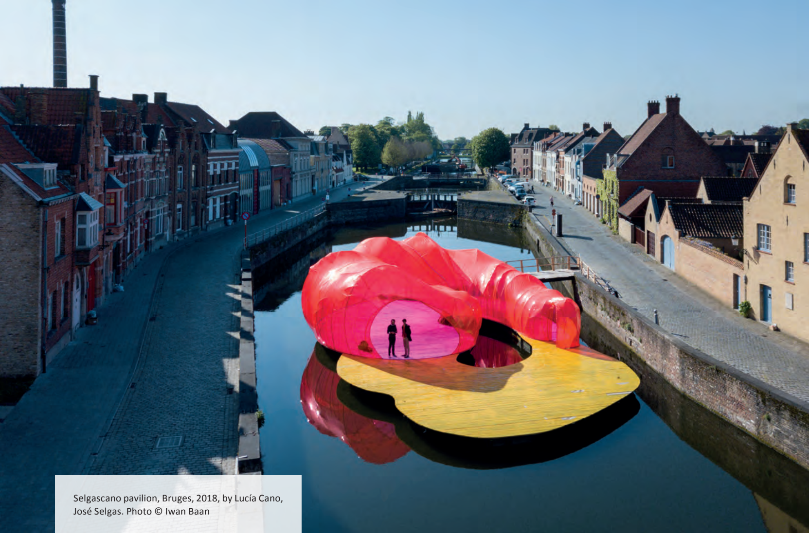
Nel padiglione sull'acqua di SelgasCano l'involucro impermeabile era montato su una piattaforma galleggiante in legno dipinta di giallo al fine di risaltare sull'acqua scura del canale. Photo © Iwan Baan
